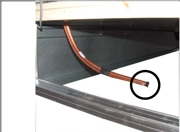
Fig. B: dettaglio punto di lavoro; tubi di connessione.
