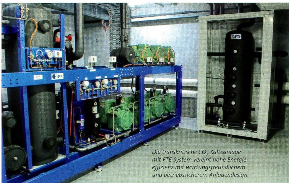
Die transkritische CO<sub>2</sub>-Kälteanlage mit FTE-System vereint hohe Energieeffizienz mit wartungsfreundlichem und betriebssicherem Anlagendesign.
