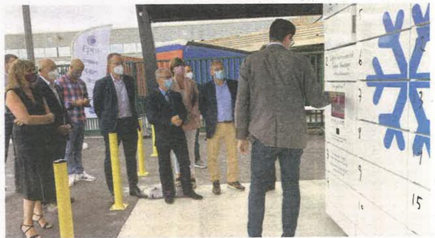
Les consignes réfrigérées d'Epta sont installées allée de l'Industrie, dans la zone des Joncaux, et sont accessibles à tous. E.A.
