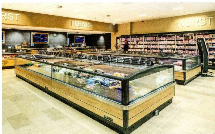
Tiefkühlinseln mit je 6,25 m Länge – die Pushdeckel öffnen sich nach hinten, sodass sich zwei Kunden bequem bedienen können
